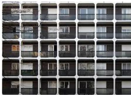
Figure 3. Ratio de surface vitrée entre 25% et 50%
