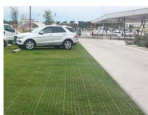
Figure 6. Surface artificialisée semi-imperméabilisée (parking pavés enherbés)
